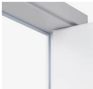
Roh zárubně z vnitřní strany
